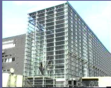
郊外型データセンター
