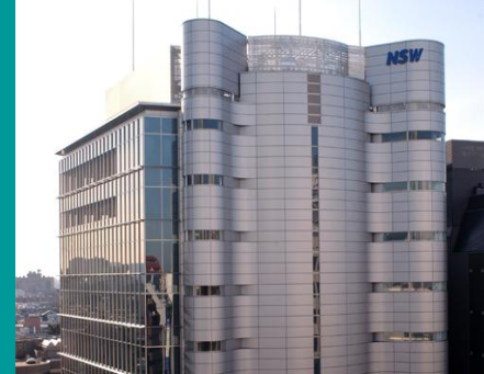
都市型データセンター
